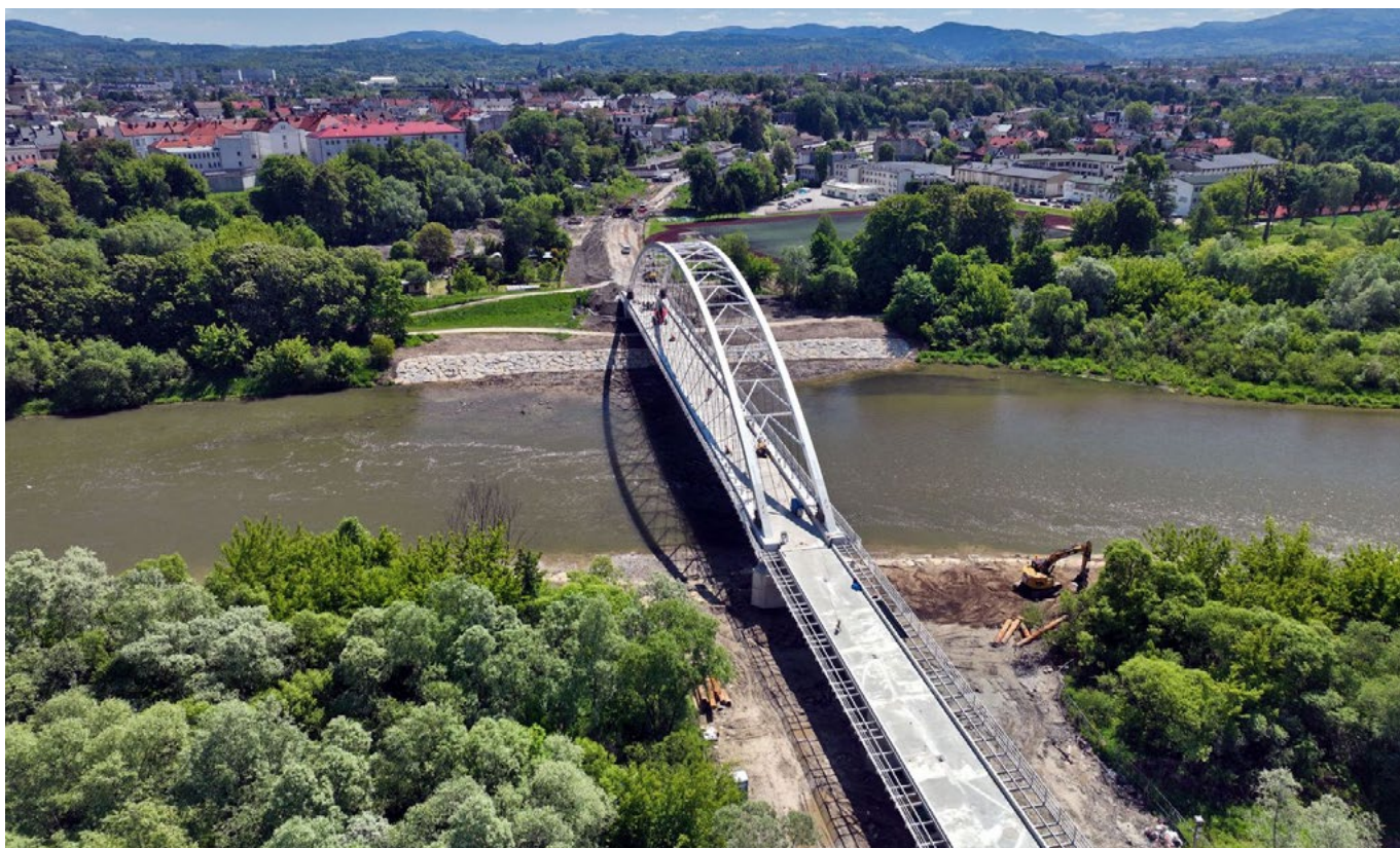
Budowa nowego mostu kolejowego na Dunajcu, fot. Krzysztof Dzialek
