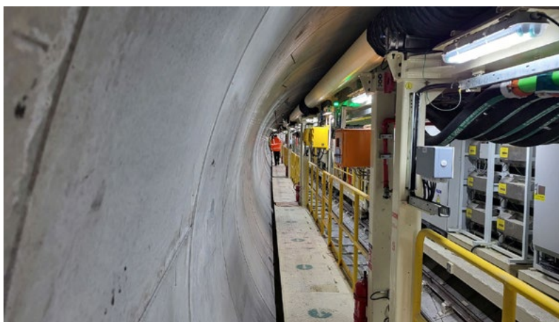
Widok wnętrza budowanego tunelu ewakuacyjnego pod Pisarzową, fot. Piotr Hamarnik
